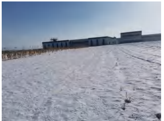
项目厂区现状 1
